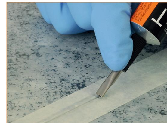
Retirer le bouchon. D'une main, presser la buse T **profondément** dans le joint afin de longer les bords du revêtement et tout en dosant avec l'autre main le débit de la pâte afin d'avoir une répartition égale sur les bandes sur une largeur de 5 mm environ.
