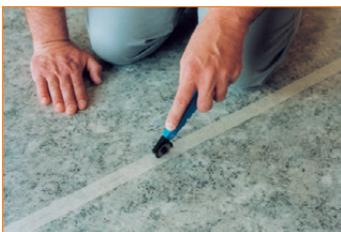
Sectionner la bande adhésive à l'aide d'une roulette de découpe. En variante, il est également possible d'utiliser un couteau avec une lame trapézoïdale ou à crochet. En cas de revêtements de sol PVC peu flexibles (des revêtements synthétiques par ex.) le fait de chauffer (max. 40°C à l'aide d'un sèche-cheveux ou d'un fer à repasser) la zone du joint avant la soudure.
