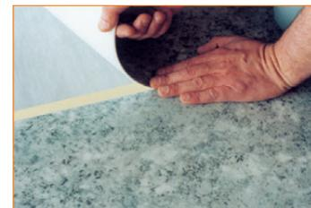
Fixer la ligne de soudure au sol à l'aide d'une bande adhésive double face ou une colle adaptée pour revêtement de sols.
